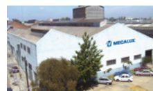
Postrojenje u Buenos Airesu, Argentina
